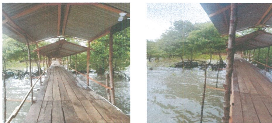
Gambar 3. Jembatan di dekat pantai desa Kelembak
